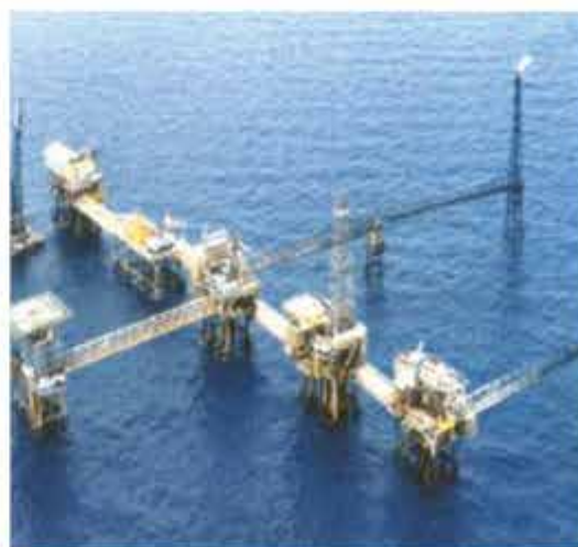
FABRICACIÓN E INSTALACIÓN DE PLATAFORMAS Y MÓDULOS DE COMPRESIÓN
